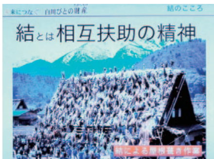
『結』による屋根葺き作業
